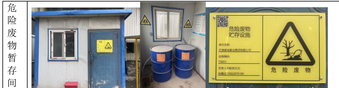
图 2-7 危险废物暂存间规范化照片
