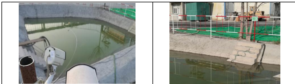
图 2-5 厂区集水池（2700m 3 ）
