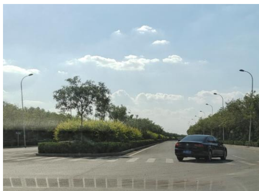
图 6 未设置分隔带右侧行驶标志
