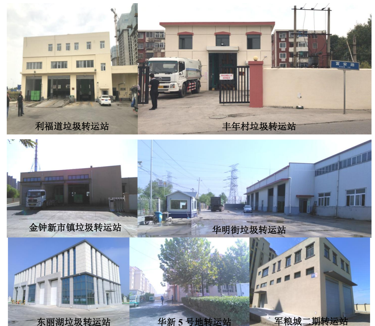
图 3-1 生活垃圾转运站现状
