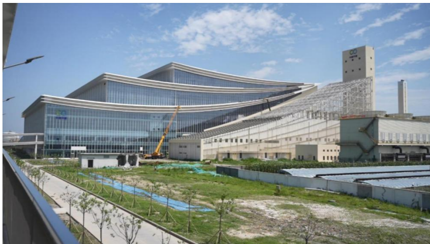
图 3-2 东丽区生活垃圾综合处理厂
